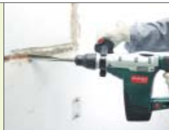
Pura rutina: Acanalar mampostería y hormigón con el KHE 56.
